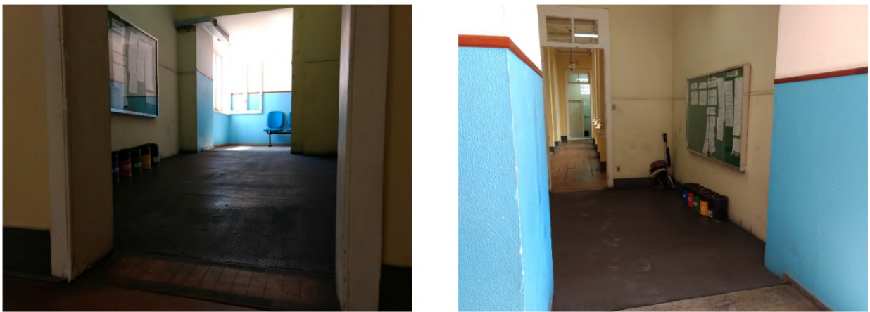
Figura 5 - Instalação de rampas entre os ambientes desnivelados.
